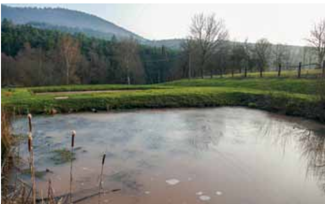
Bassin de décantation - St Pierre Bois
